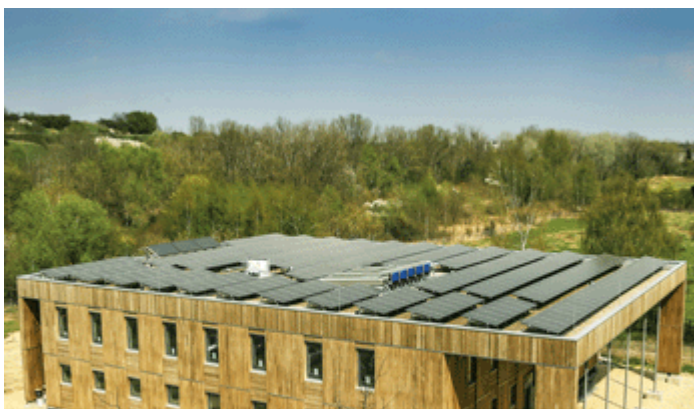
281 moduli solari HIT forniranno all'edificio del Ministero dell'Ambiente tedesco energia pulita. PhCredit: Jörg Völker, AS Solar
